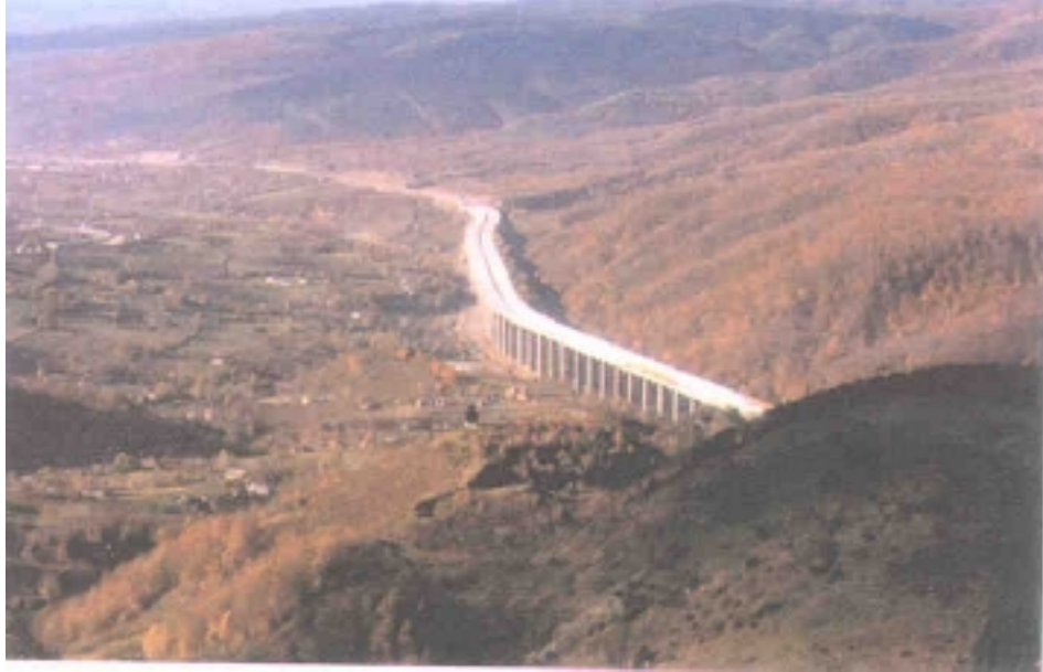
Şekil 2 Viyadük 1’in Genel Görünüşü
